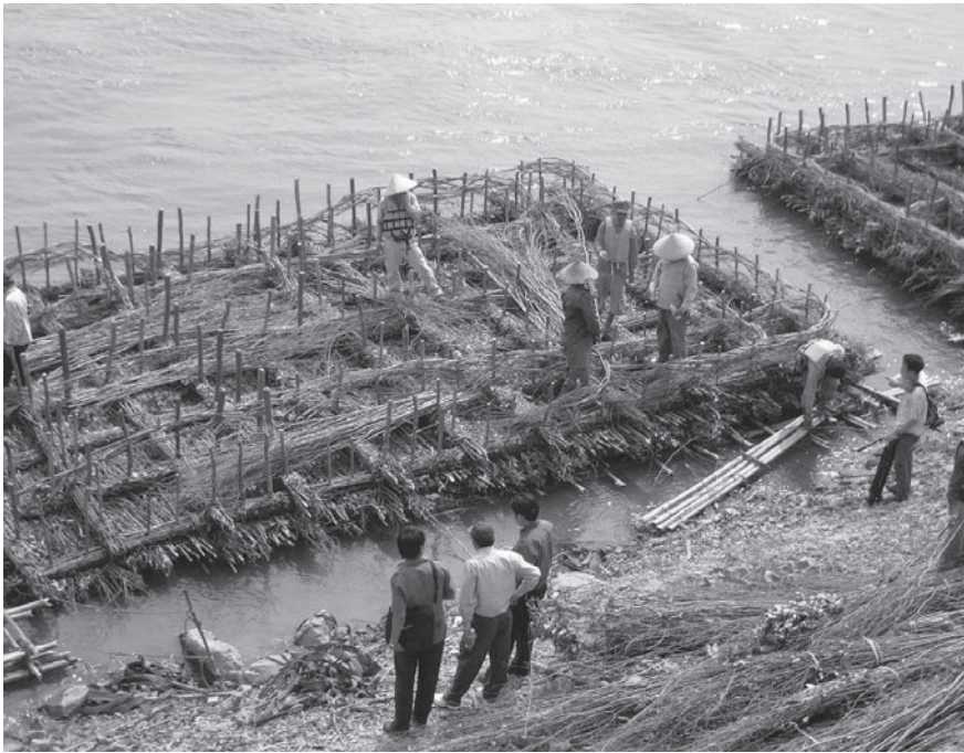
写真3 過去のJICAプロジェクト(2001～2004年)における粗朶沈床工の施工(2006年3月) (小林六郎氏撮影)
