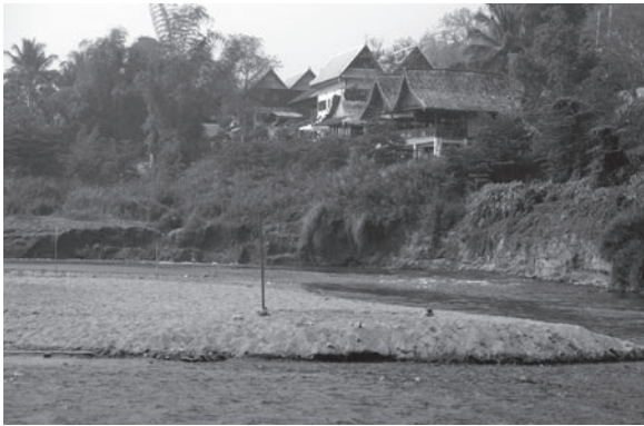
写真2 メコン河支川(ルアンパバン周辺)における河岸侵食被害 (2010年2月)
