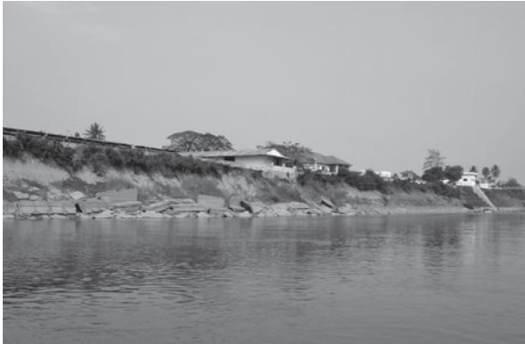
写真1 メコン河本川(ピエンチャン周辺)における河岸侵食被害 (2010年2月)
