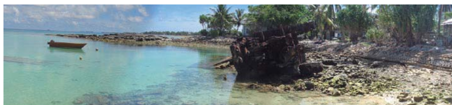
写真2 フォンガファレ島ラグーン側の海岸。戦時中に建設されたスリッパウェイ(写真左奥)や浚渫跡(写真左手前)が起因し砂浜が消失し、荒天時には高波が海岸近くの住居や学校を襲う。海岸には戦時中に使用された掘削機が無残に横たわる
