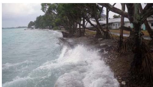
写真1 2010年1月の大潮時に低気圧が接近したときの越波の状況。近くには政府庁舎やツバルを訪れる外国人の多くが宿泊する国营ホテルが立ち並び
