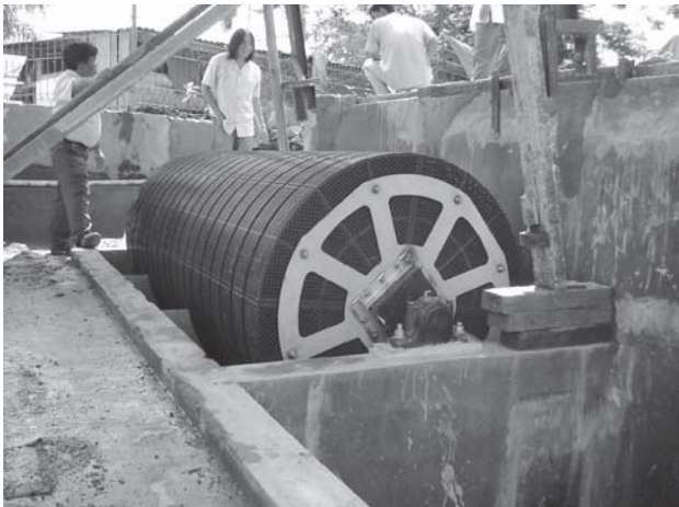
図2 立体格子状接触体を用いた回転円板
