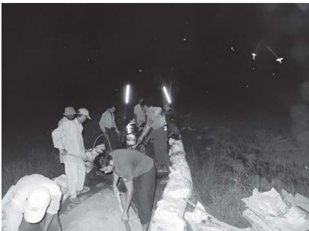
図14 夜勤での作業状況(ミャンマー)
