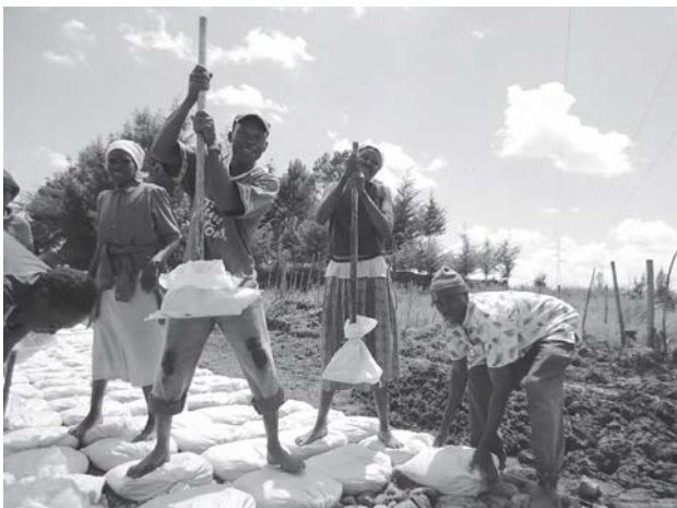
図7 土のう締固めを行う農家(ケニア)
