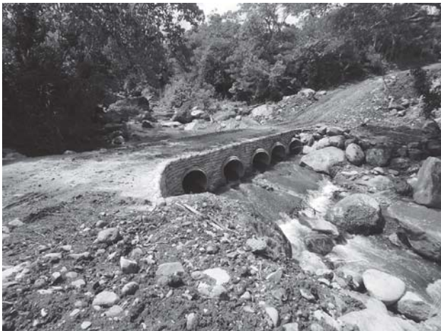
図 16 建設された沈下橋（フィリピン）
