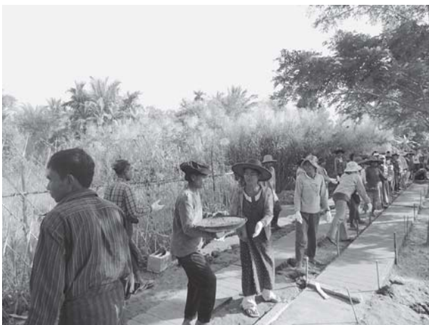
図13 コンクリートの運搬状況(ミャンマー)
