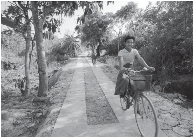
図12 施工後の様子(ミャンマー)
