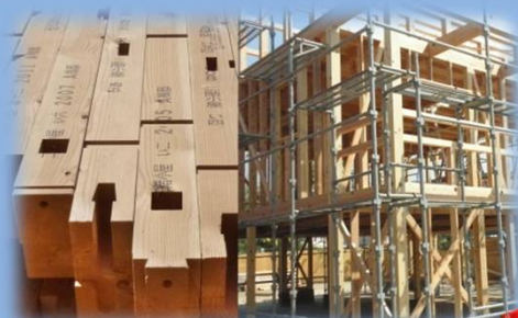
プレカット加工した構造材を使用した木造建築
