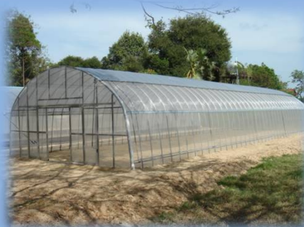
ネットハウス ハウス全体のカバーに目の細かいネットが使用されている
