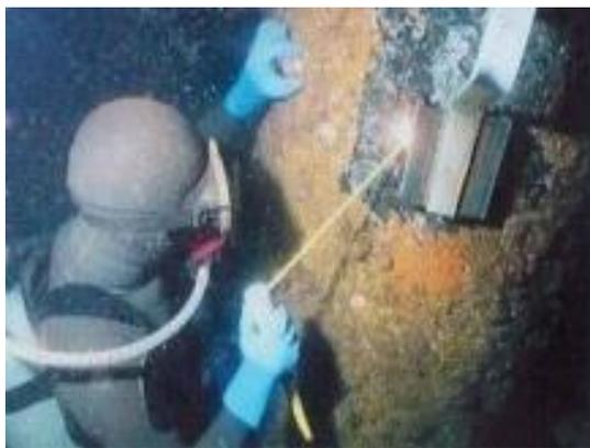
▲ 水中溶接による電気防食の施工
