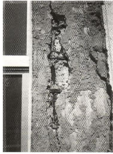
写真-4 センター柱のひび割れ
