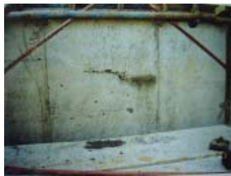
写真-20 土留擁壁のコールドジョイント写真-21 コールドジョイントができた水槽壁
