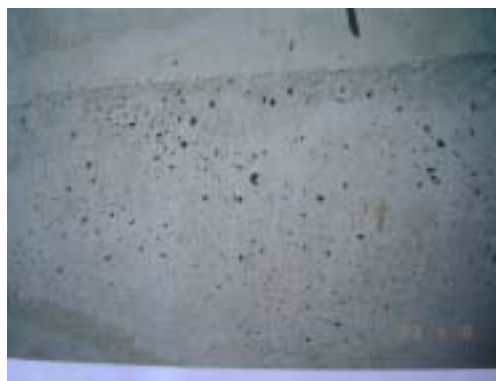
写真-23 大型の気泡ができた擁壁
