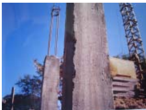
写真-24 角が欠けた柱
