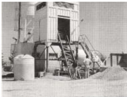
写真 - 1 フェズの生コンクリート工場
