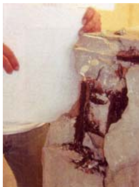
写真-16 海水用水槽壁を除去後
