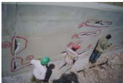
写真-20 土留擁壁のコールドジョイント写真-21 コールドジョイントができた水槽壁
